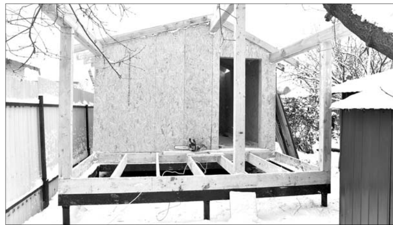
Каркас нового дома.
