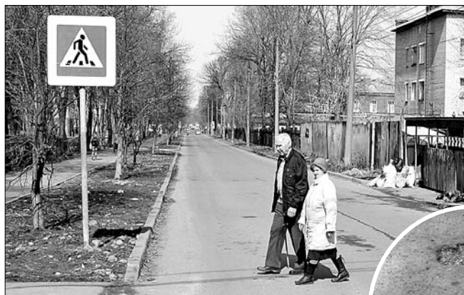
Трещины на Краснопереконской улице.
