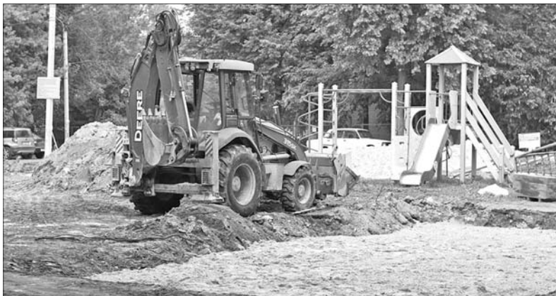
Работы по благоустройству двора домов 43 и 43а по улице Чехова.
